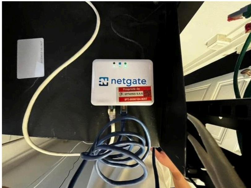
**Figure 6** : Photo du routeur Pfsense. Le câble blanc vient de la box internet, le câble bleu va vers le switch général.
